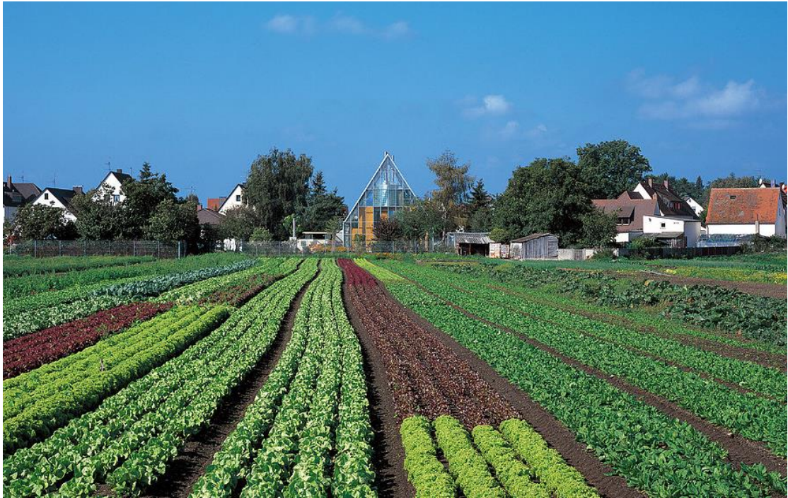
Figure 45: View of the greenhouse residence in Knoblauchslad (Niederwöhrmeier + Kief Freie Architekten BDA und Stadtplaner)
