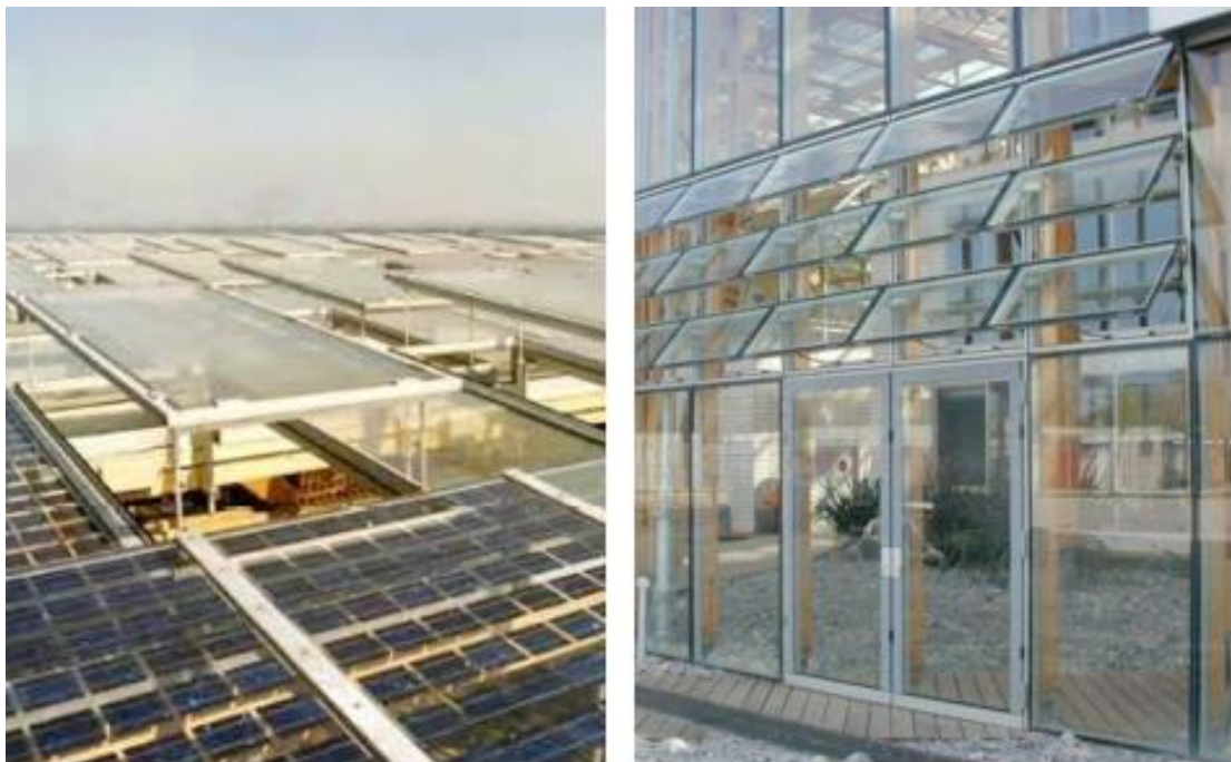
Figure 50: Natural Ventilation in Mont Cenis Academy (Kuok Hong, Hoi Kiu and Jin Sol, 2013)
